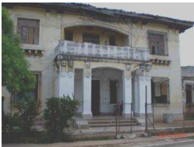
Foto de uno de los edificios de Torrecilla
